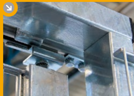
STABILE TÜRTRVERSE auch zur Kabelführung geeignet
